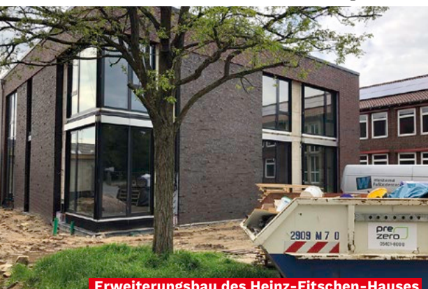
Erweiterungsbau des Heinz-Fitschen-Hauses
