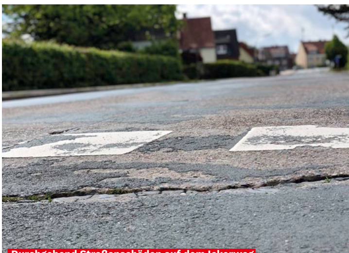
Durchgehend Straßenschäden auf dem Ickerweg
